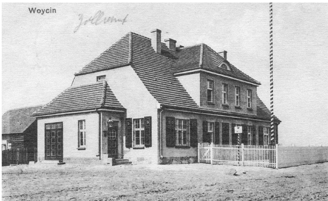
Budynek na przejściu granicznym w Wójcinie. Początek XX wieku
